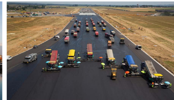
Renovatie start- en landingsbanen Brussels Airport
