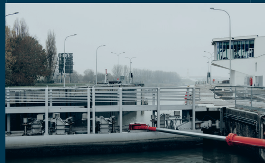
Renovatie sluisdeuren (Zemst)
