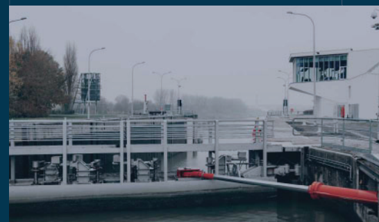
Renovatie sluisdeuren (Zemst)
