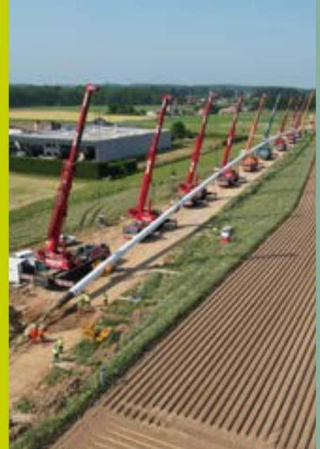
44 km hydrogen-ready gaspijpleiding Opwijk-Desteldonk
