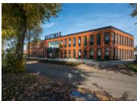
Kantoorgebouw Adifo Maldegem
